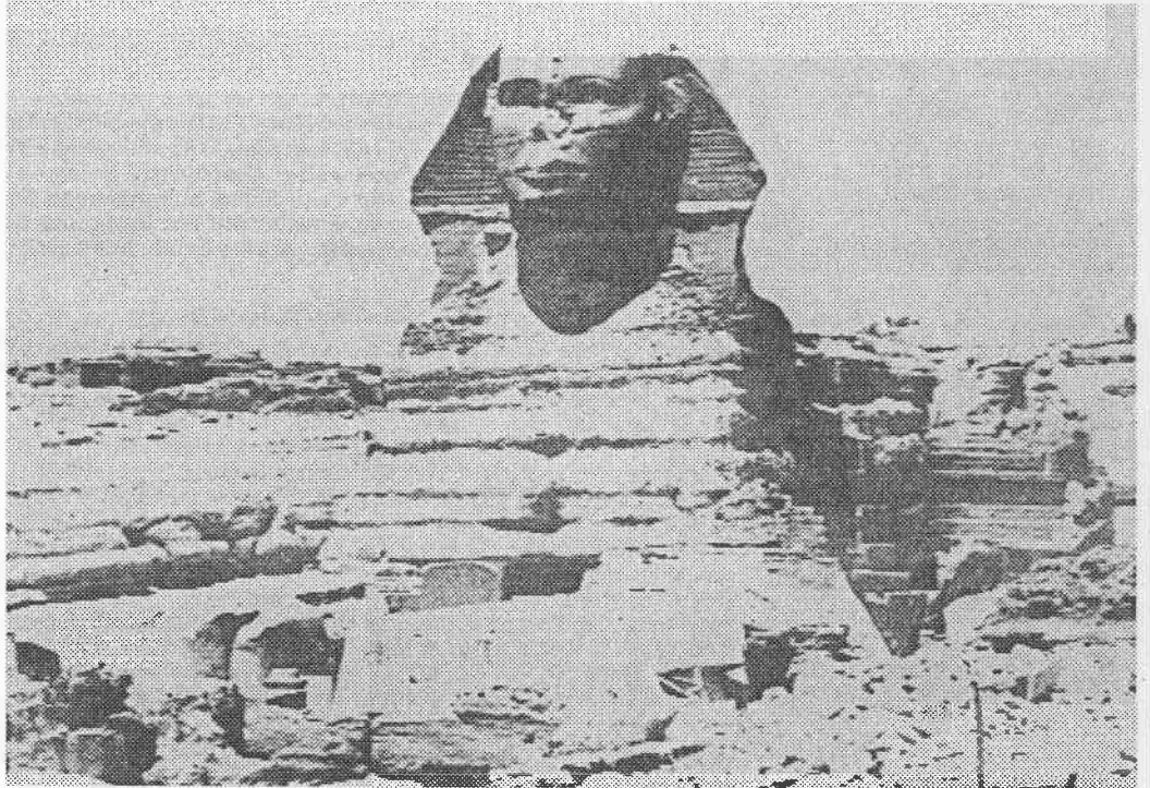
20 Tonnen schwer ist der Kopf der Sphinx. Hals und Brustpartie sind durch Großstadtsmog, Autoabgase und Grundwasser schon so geschädigt, daß er bald abzustürzen droht.
